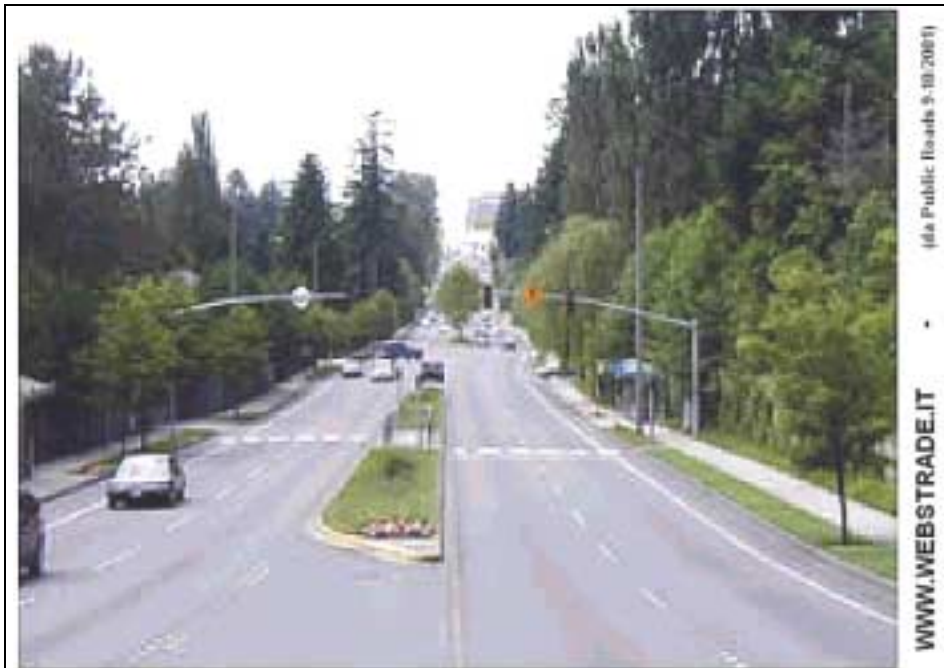
Figura 10 — Benché questa sia una strada ad alto volume ed alta velocità, l'attraversamento con isola separatrice rende il passaggio del pedone più sicuro, con l'impiego di un semaforo completamente a chiamata ed un marciapiede centrale tipo "jog" o "a pellicano" che costringe il pedone a guardare nella direzione del traffico in (Foto: Aida Berkovitz)
