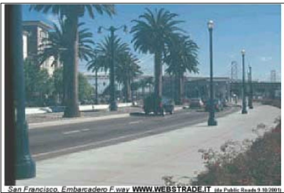
Figura 5 — Questa strada a San Francisco ha sostituito l'Embarcadero Freeway,
