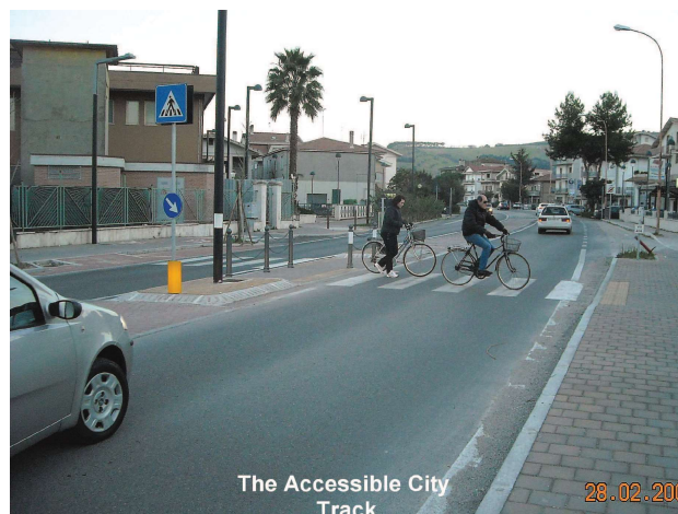
Attraversamento a Pellicano nel tratto centrale urbano della Variante alla SS.16, in precedenza, una strada pericolosa, inaccessibile agli utenti deboli
