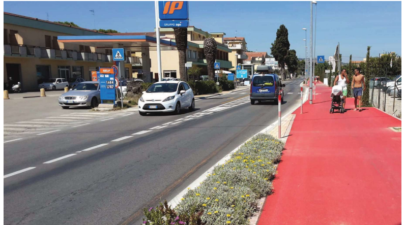
Percorso ciclopedonale con colorazione intensa, lungo una strada principale di traffico. Trattamento a verde dei bordi del percorso. Variazione orizzontale della carreggiata con sistemazione delle fermate Bus, contrapposte davanti all'attraversamento pedonale.
