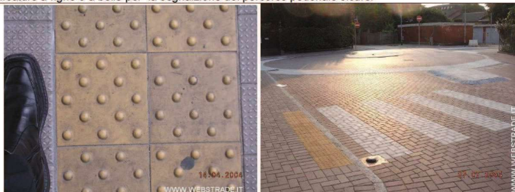
Fig.Part. 5b-5c - Masselli ipovedenti a bolle, ad indicare la fine del percorso sicuro e la presenza di un attraversamento valicabile di strada di traffico. Esempio di impiego su una minirotatoria su piattaforma rialzata a Comaredo (Webstrade.it, 2004)
