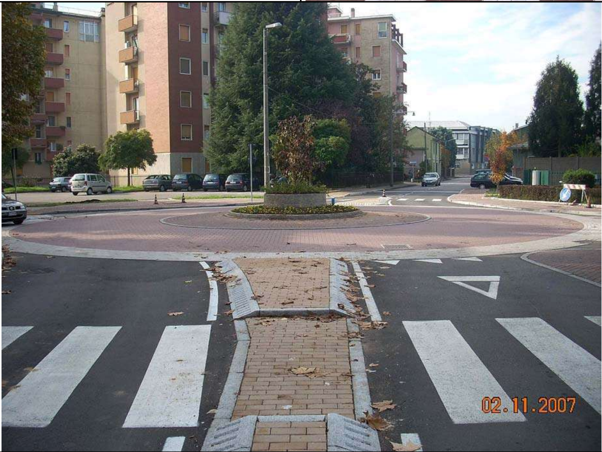
Rotatorie compatte urbane diametro 22-26 m a Cornaredo
