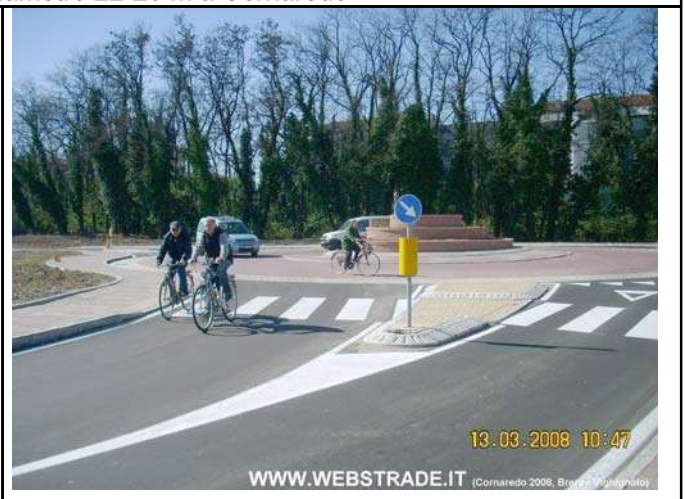
Rotatorie compatte urbane diametro 22-26 m a Cornaredo
